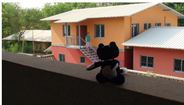
Nouveau bâtiment d'accueil
